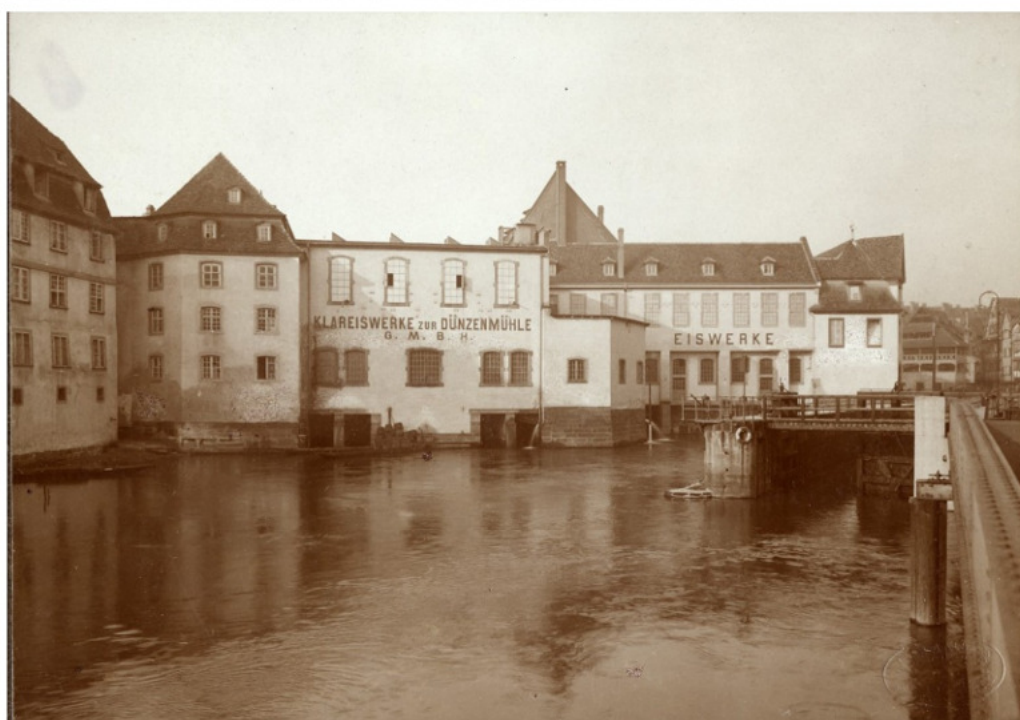
1903 après travaux de l'usine des glacières
